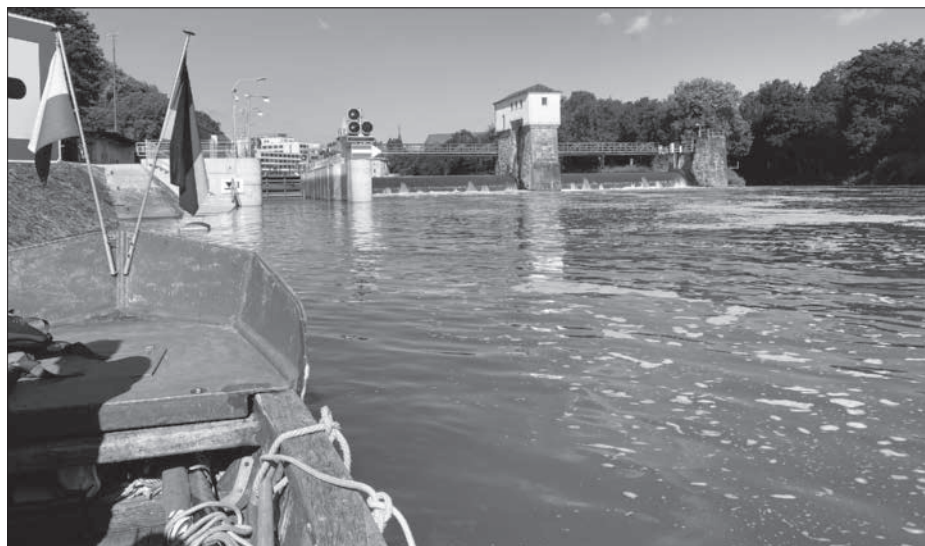
Die neue Schleuse in Kassel bringt uns die Fulda hoch zur Fahrt durch die Stadt.
