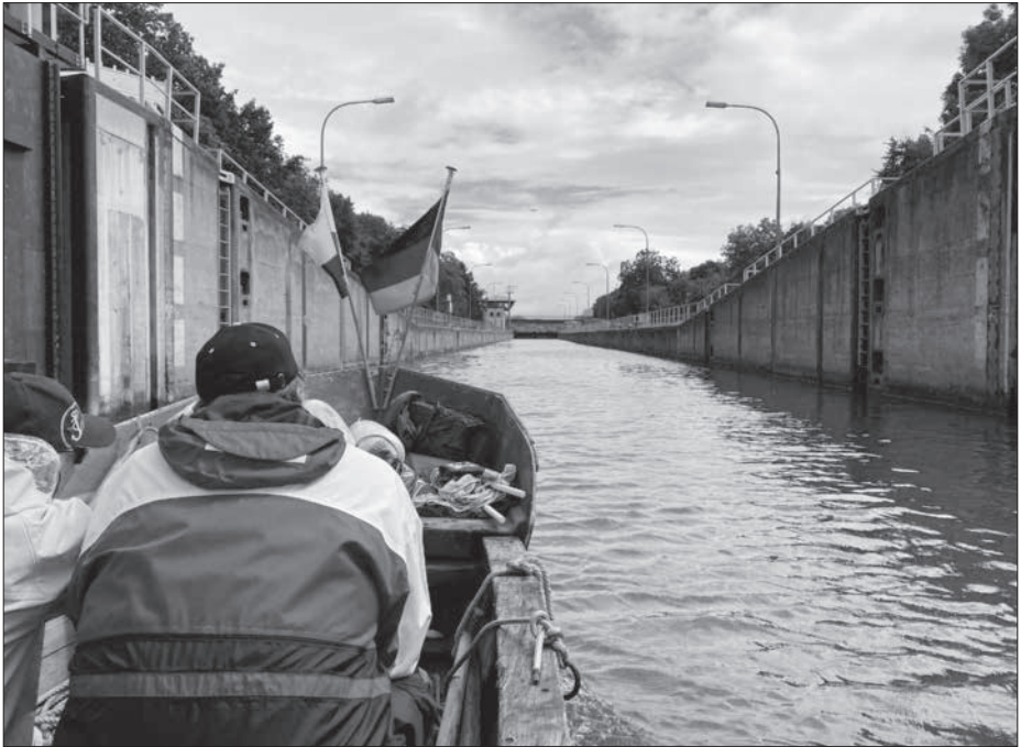
Die Schleuse Schlüsselburg hat beeindruckende Abmessungen und noch viel Reserve neben dem Birago-Ponton.
