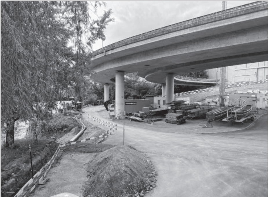
Start der erster Arbeiten beim Pontonierhaus. Die Einwässerungsstelle war im Mai/Juni 2024 nicht benutzbar.
